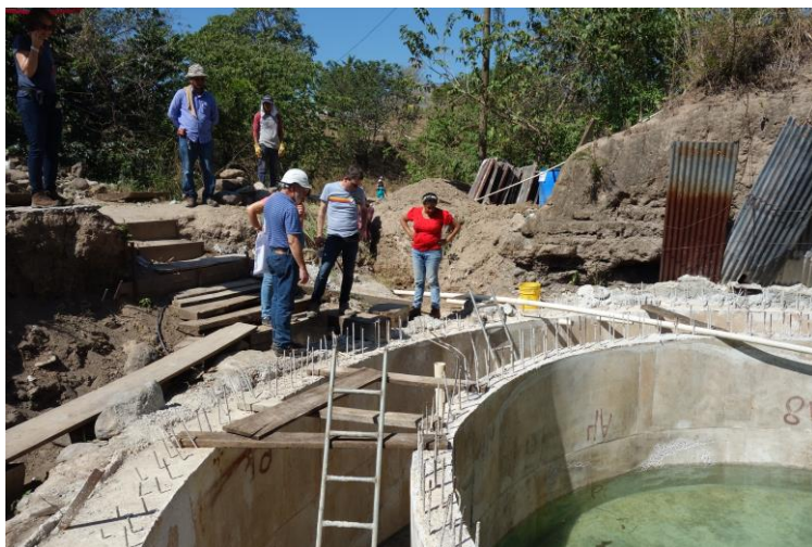
Der Tank ist betonierte und wird gerade zur Dichtungsprobe gefüllt
