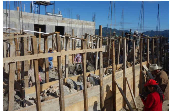
Bau eines einfachen Wassertanks in Huitán
